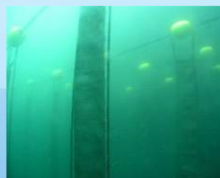
Пример установки комплектов под водой
